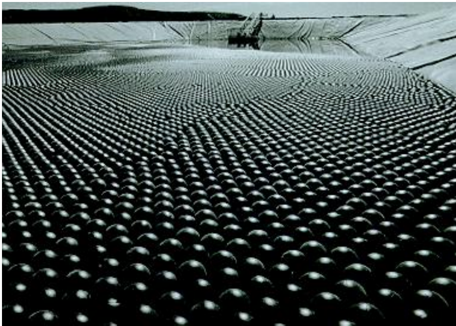
Bolas Flotantes para aves cubre la superficie de un dique de colas en la mina de oro Cortez, un Joint venture entre Placer Dome y Kennecott en Nevada USA
