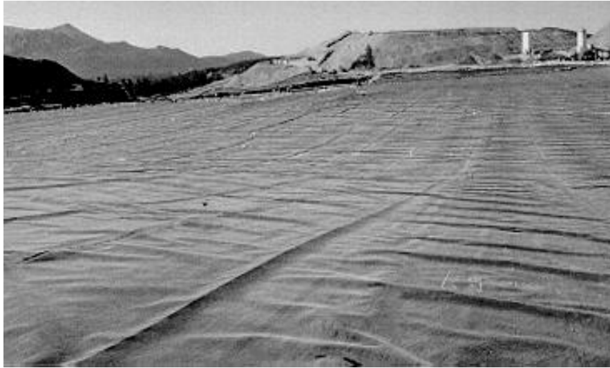
Construcción de una planta de lixiviación en Pikes Peak, Colorado, USA
